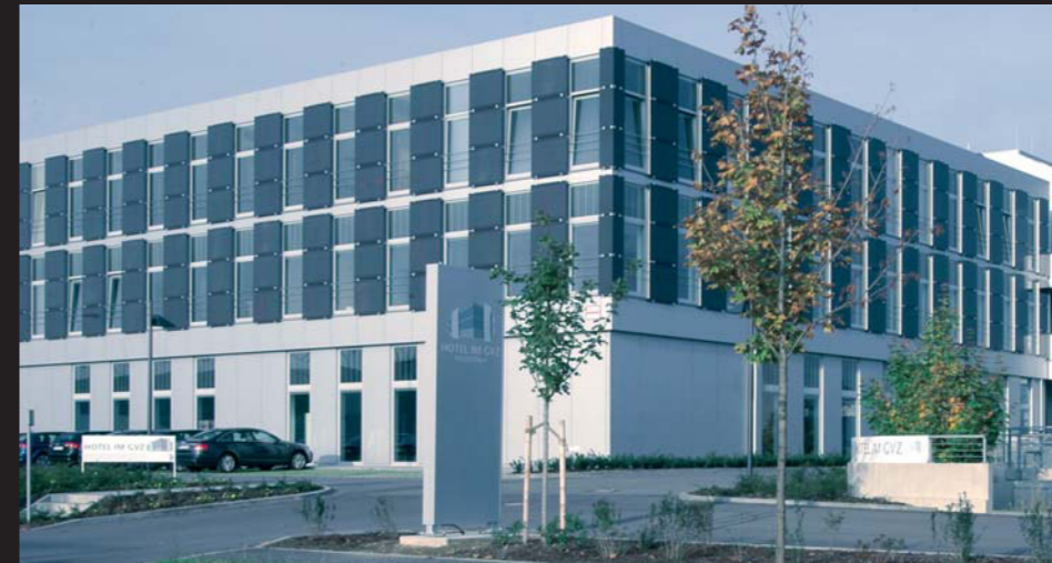
HOTEL IM GVZ, INGOLSTADT
