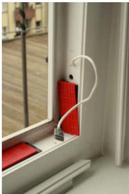
Ex.: Kabel, Klotzung / Cable, setting blocks
