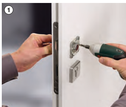
1 Unterkonstruktion aufstecken und festschrauben
