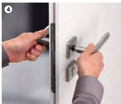
4 Griffe zusammenstecken und Innensechskant-Schraube festziehen
