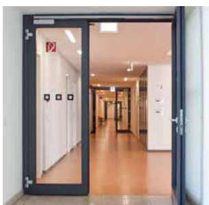
Sicherung im Objekt
